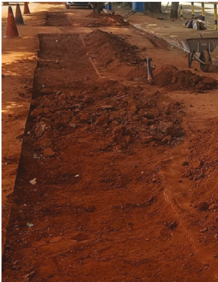
Valas abertas para execução de obras e serviços na rede de água ou esgoto, em grande parte das vezes, ficam abertas por várias semanas
